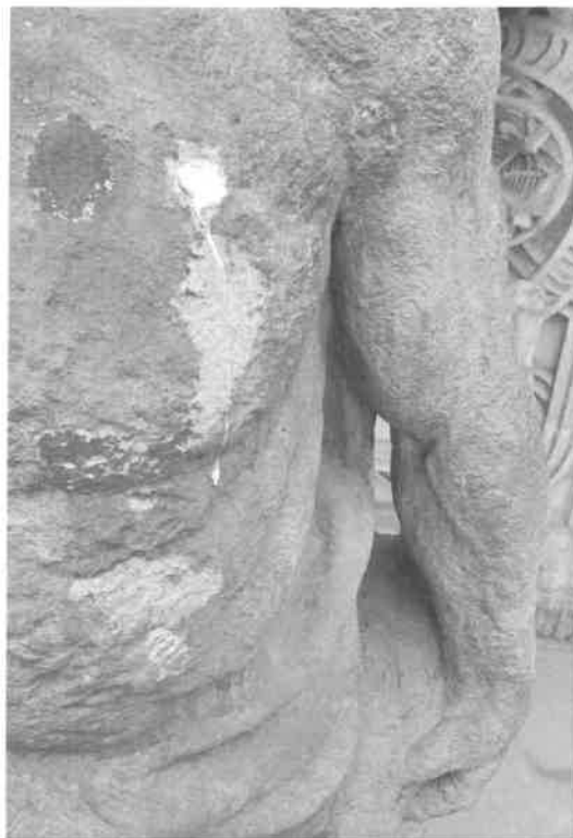
vyžilé tmely, povrchové znečištění
