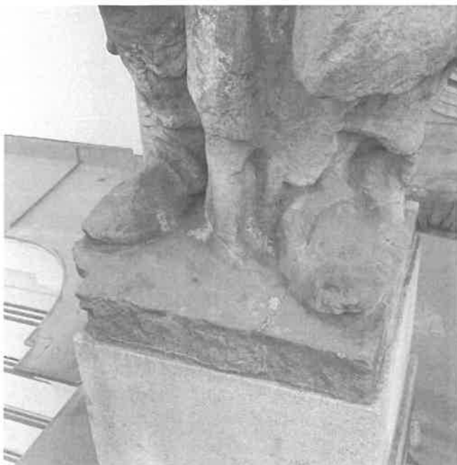
Partie nohou s podélnou prasklinou v plintu.
