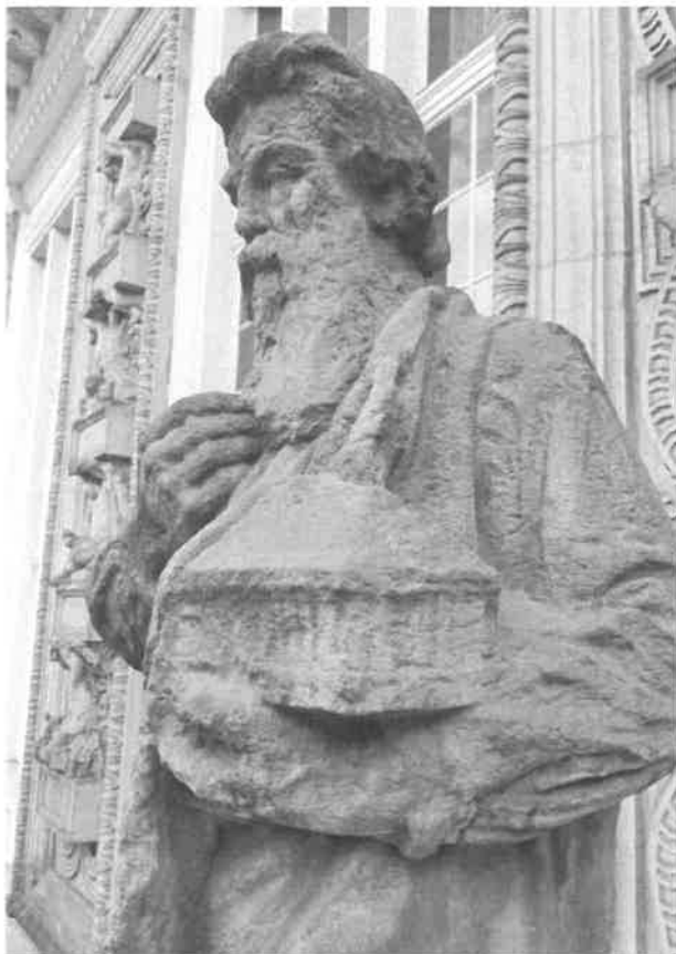
Degradovaný povrch, ztráty modelace
