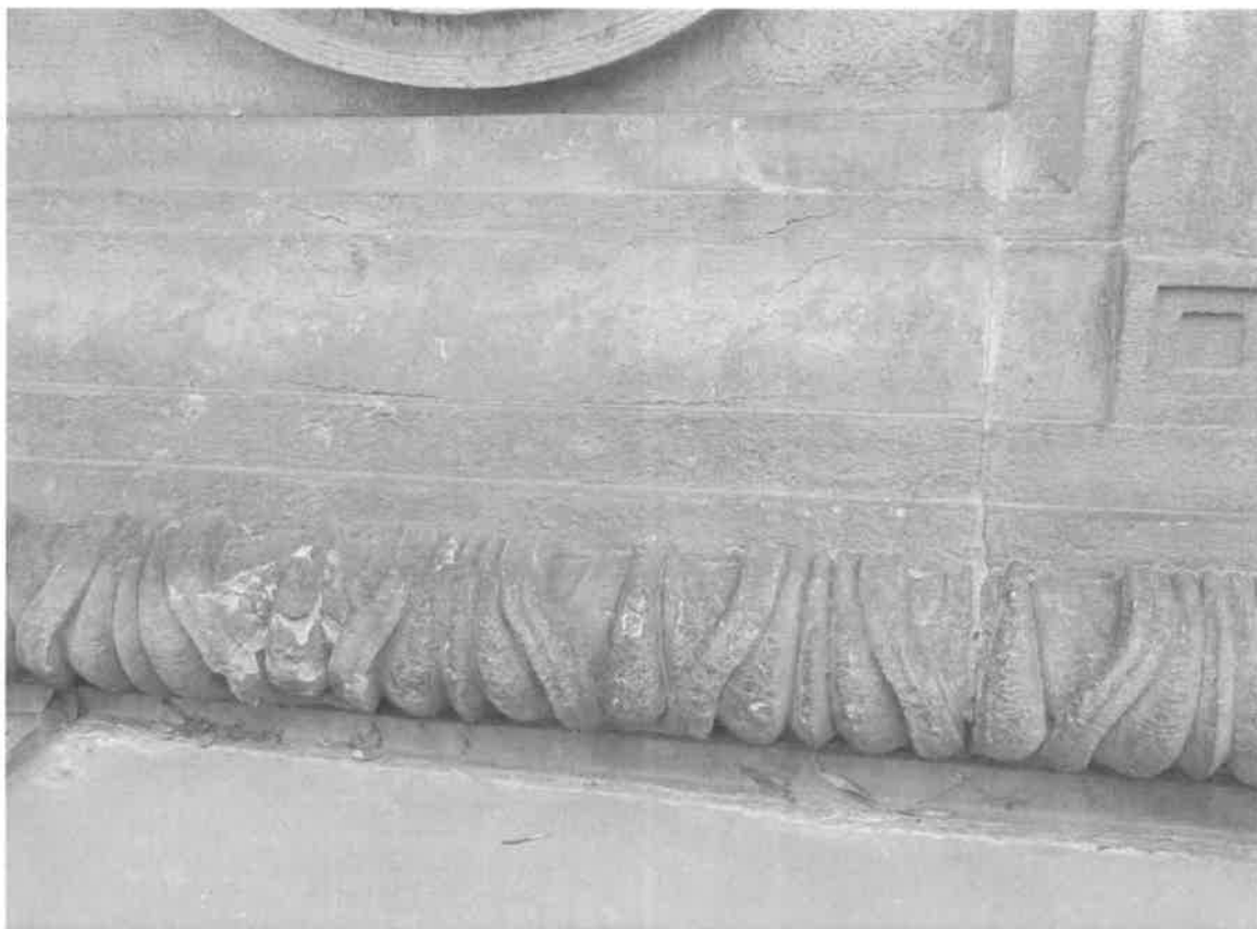
trhliny ve spodních partiích reliéfů
